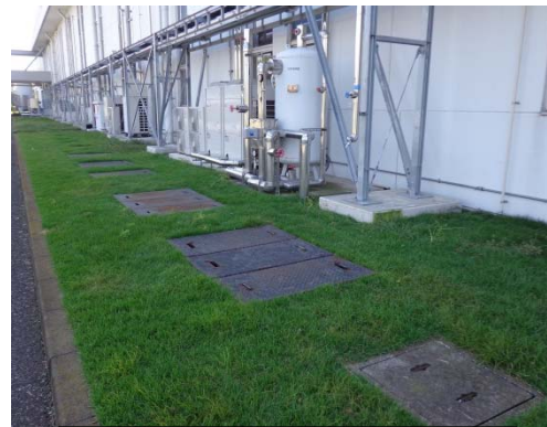
群馬工場（東大室）浄化槽 (地下埋設)
