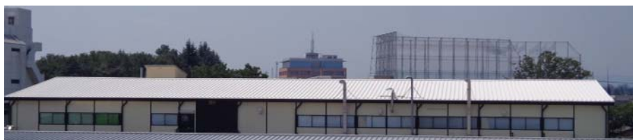
前橋工場 モールド建屋遮熱塗装 ※白色塗装部分
