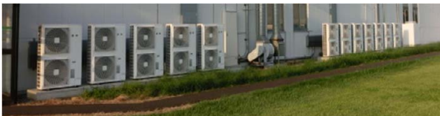
群馬工場 空調室外機遮熱塗装 ※白色塗装部分
