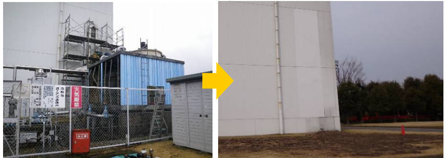
群馬工場 ボイラー、地下タンク撤去
